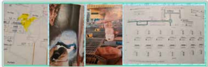
Εικόνα 6 Εμφράξεις στο 2ο και 3ο πέρασμα του ατμολέβητα. Υδροδυναμικός καθαρισμός shower cleaning στο 2ο και 3ο πέρασμα του ατμολέβητα
